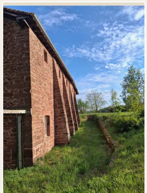
Strebepfeiler an der Fassade
