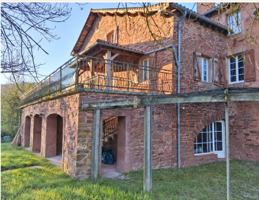
Hauptzugang und Steinbögen
